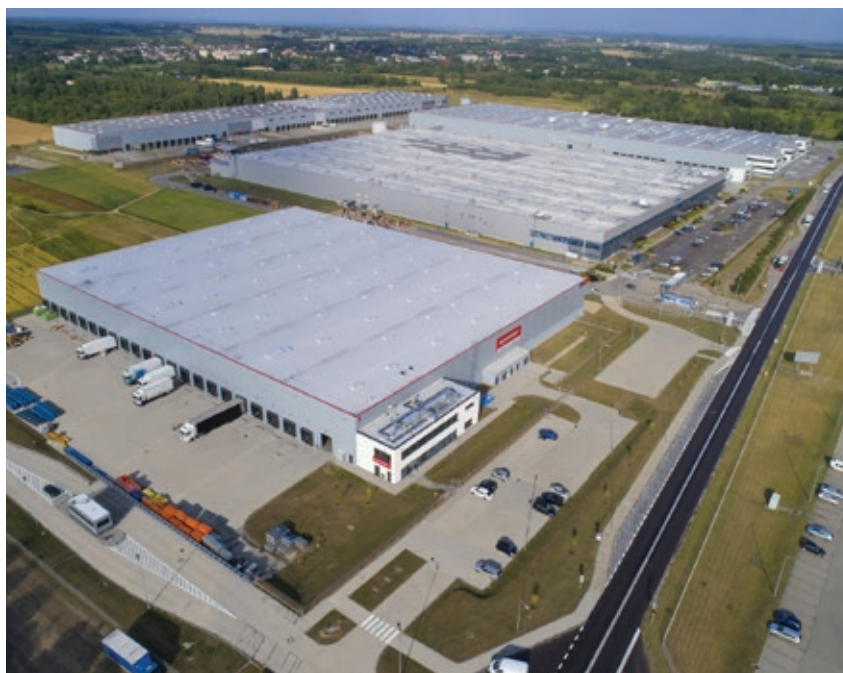
Jedna z najnowszych inwestycji zrealizowanych przez SEGRO dla firmy KOMFORT na terenie SEGRO Logistics Park Stryków
