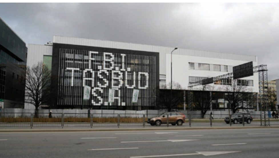
Innowacyjny budynek z ruchomymi panelami elewacji DK Kadr Innovative building with movable modules DK Kadr
