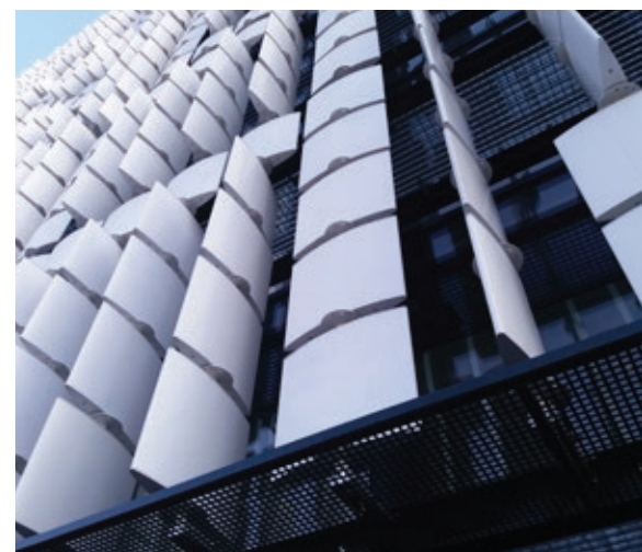
Innowacyjny budynek z ruchomymi panelami elewacji DK Kadr Innovative building with movable modules DK Kadr
