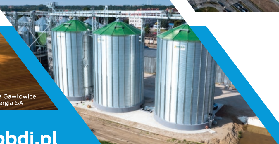
Budowa kompleksu silosów zbożowych w Białogardzie. Inwestor: AMPOL-MEROL sp. z o.o.
