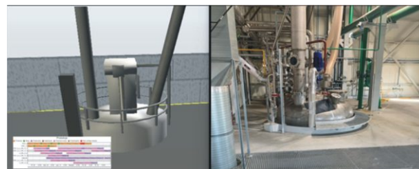
Jeden z reaktorów, który jest częścią zespołu specjalistycznych reaktorów, zapewnia możliwość produkcji wysokospecjalistycznych żywic zarówno w środowisku symulacyjnym, jak i rzeczywistym.
